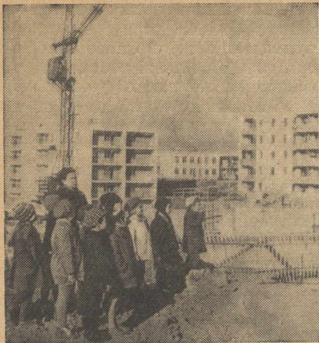
Експерсія на будівництво.
