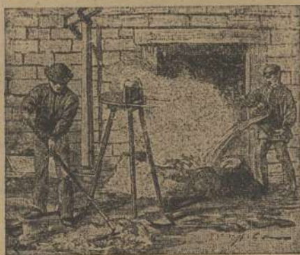
Мал. 167. — Муляр робить цемент. Муляр робить вапно.
