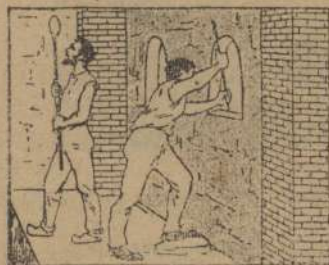
1. — Робітник бере з казана розтопленого шкла. Для цього він устромляє туди залізу руру.
